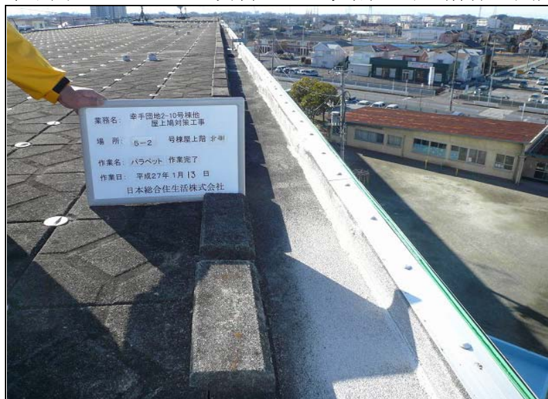
No. 43 5-2号棟・北側 パラペット 作業完了
