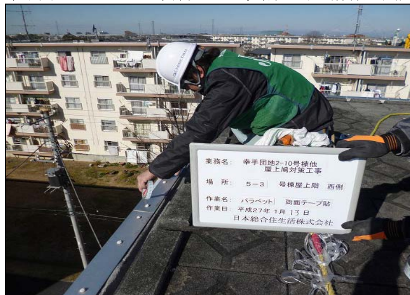
No. 49 5-3号棟・西側 パラペット 両面テープ貼り 作業状況
