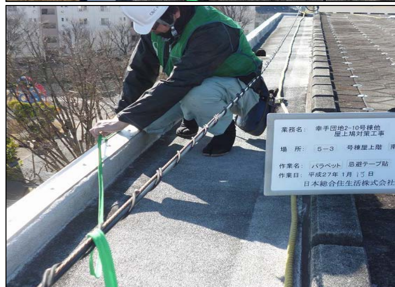
No. 54 5-3号棟・南側 パラペット 忌避テープ貼り 作業状況
