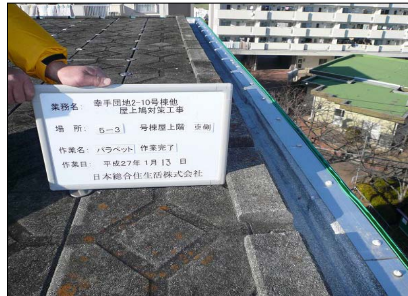
No. 60 5-3号棟・東側 パラペット 作業完了
