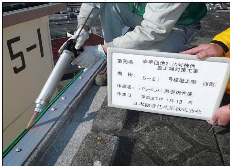
No. 37 5-2号棟・西側 パラペット 忌避剤含浸 作業状況
