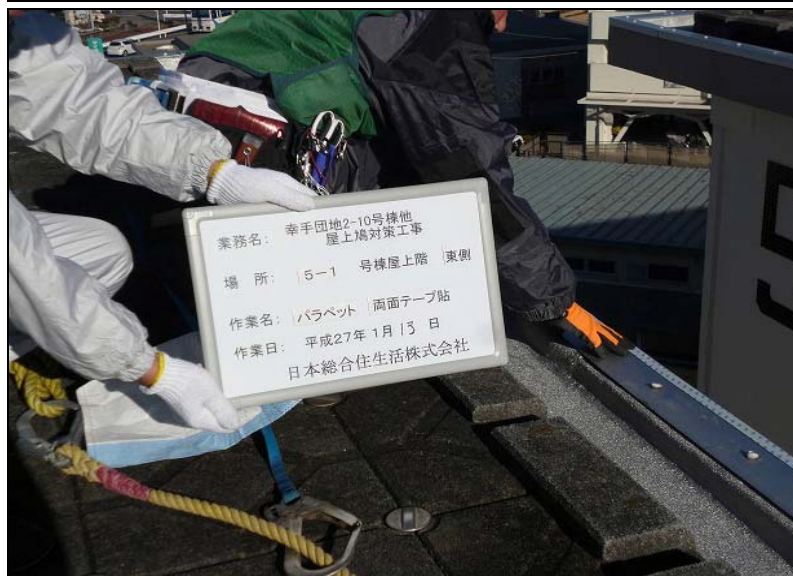
No. 8 5-1号棟・東側 パラペット 両面テープ貼り 作業状況
