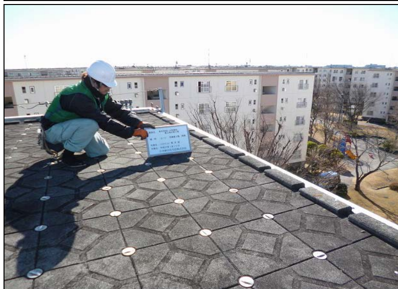
No. 45 5-3号棟・西側 着手前
