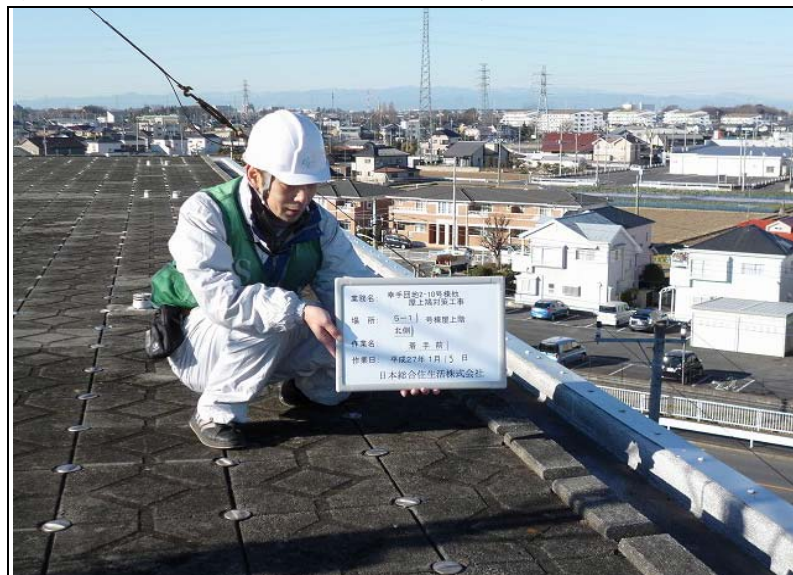
No. 7 5-1号棟・北側 着手前
