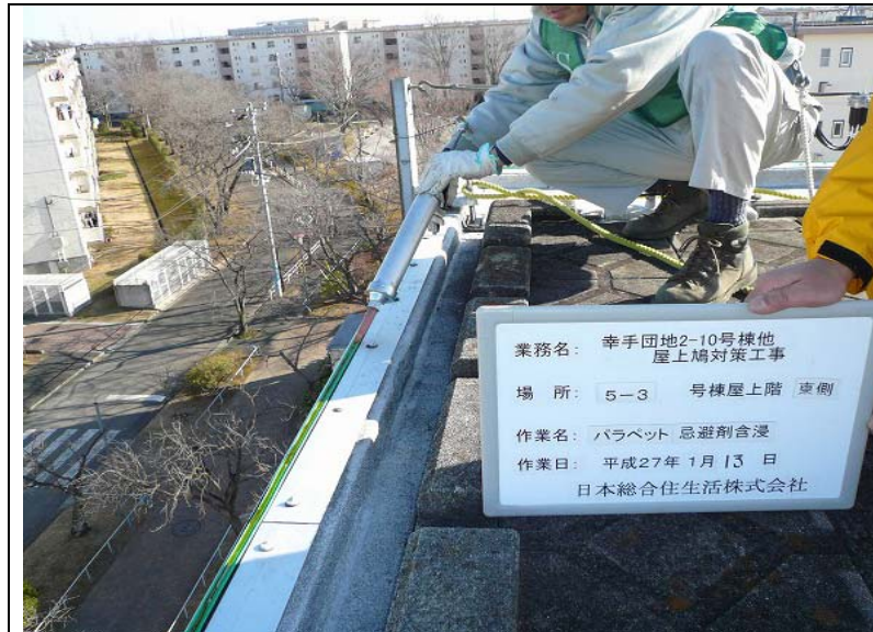
No. 56 5-3号棟・東側 パラペット 忌避剤含浸 作業状況
