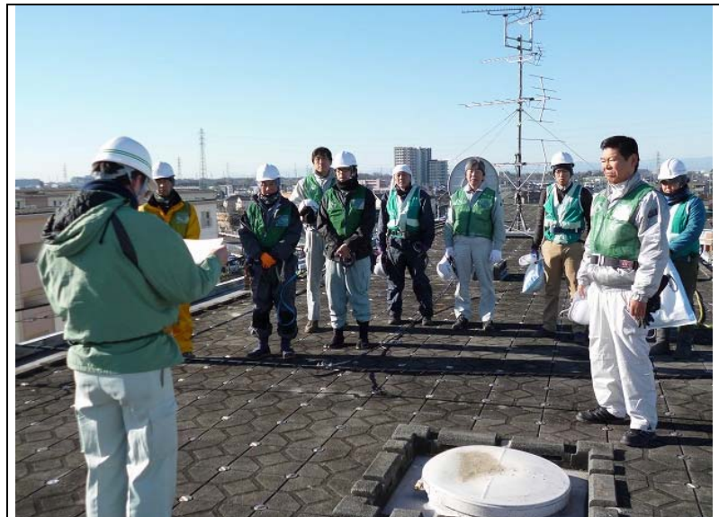
No. 2 作業開始前 新規入場 安全ミーティング 1月13日
