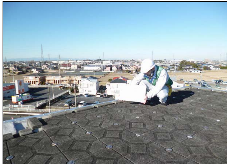
No. 5 5-1号棟・西側 着手前
