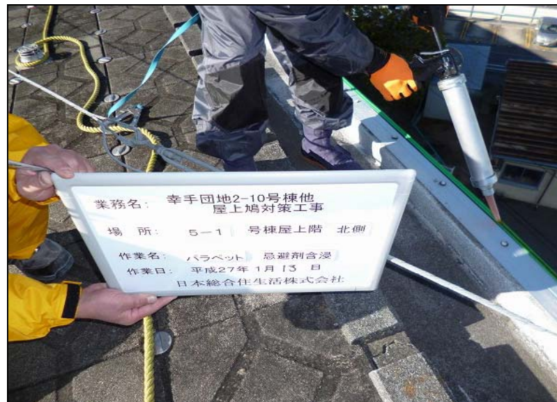
No. 19 5-1号棟・北側 パラペット 忌避剤含浸 作業状況
