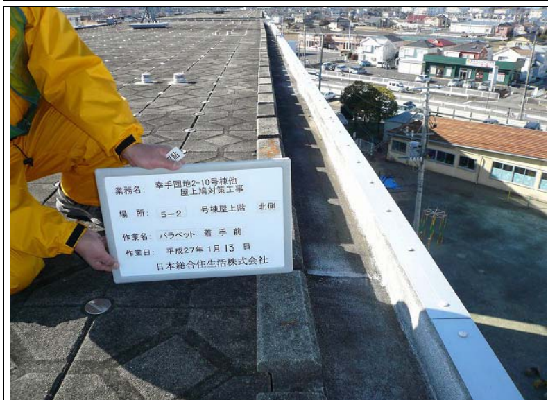
No. 27 5-2号棟・北側 着手前
