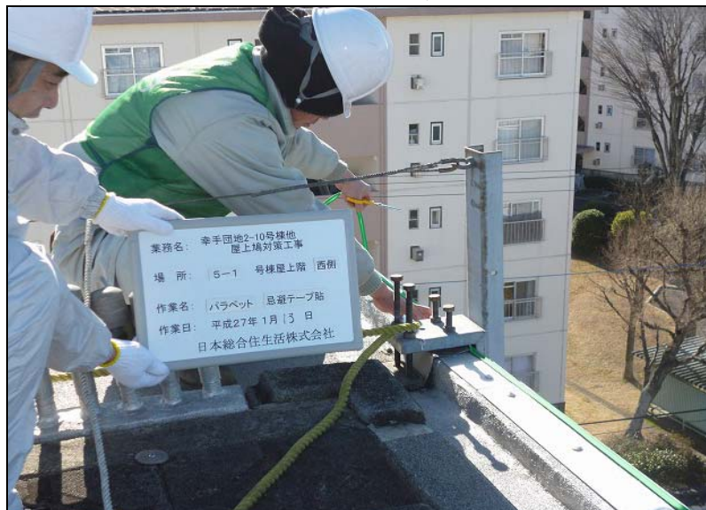
No. 13 5-1号棟・西側 パラペット 忌避テープ貼り 作業状況
