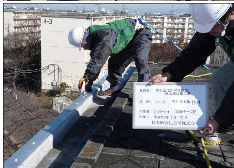
No. 51 5-3号棟・北側 パラペット 両面テープ貼り 作業状況
