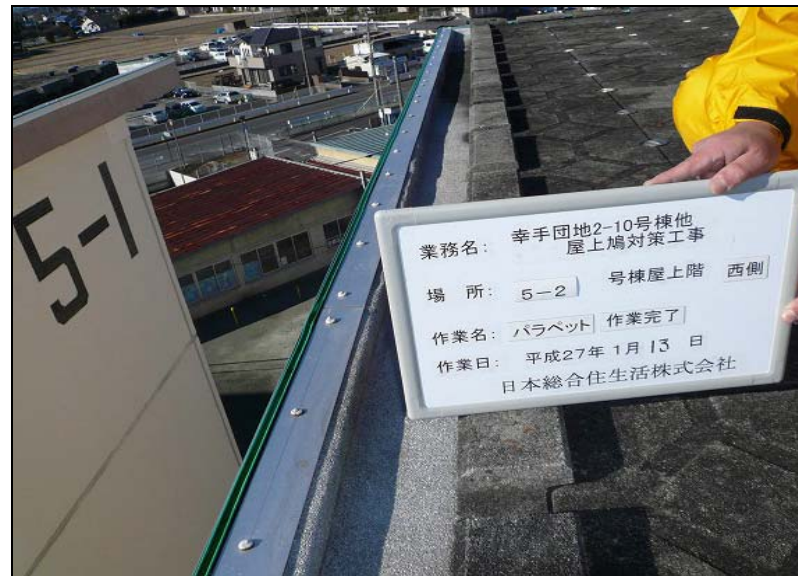
No. 41 5-2号棟・西側 パラペット 作業完了
