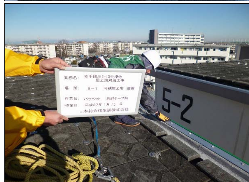
No. 12 5-1号棟・東側 パラペット 忌避テープ貼り 作業状況
