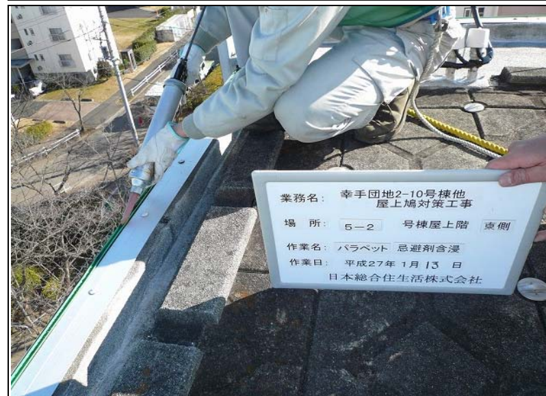
No. 36 5-2号棟・東側 パラペット 忌避剤含浸 作業状況
