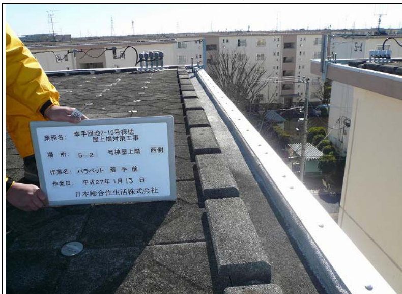
No. 25 5-2号棟・西側 着手前
