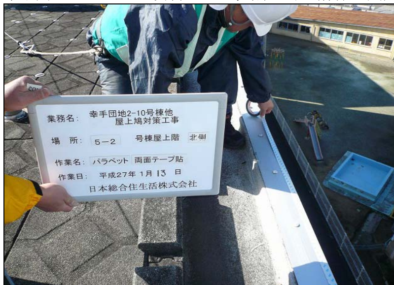
No. 31 5-2号棟・北側 パラペット 両面テープ貼り 作業状況
