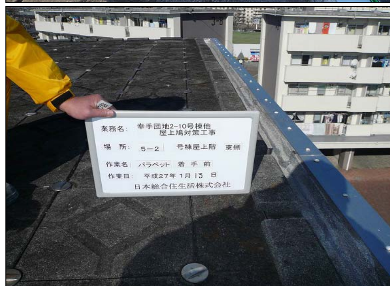
No. 24 5-2号棟・東側 着手前
