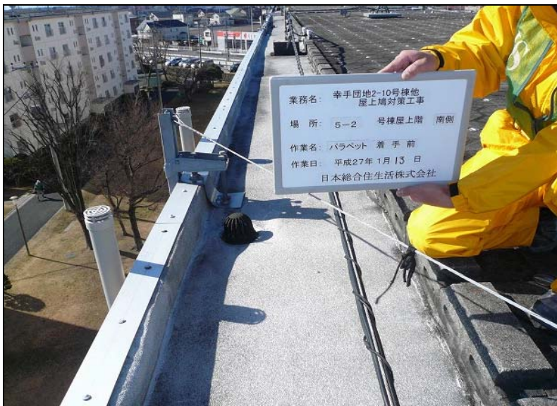
No. 26 5-2号棟・南側 着手前
