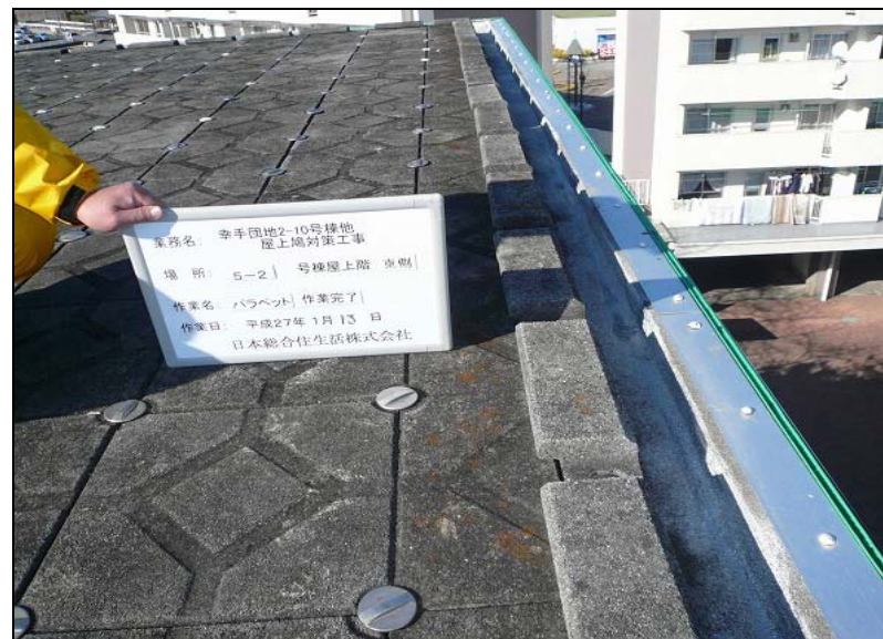
No. 40 5-2号棟・東側 パラペット 作業完了
