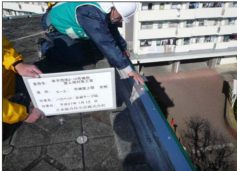
No. 32 5-2号棟・東側 パラペット 忌避テープ貼り 作業状況
