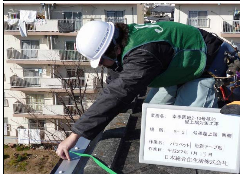
No. 53 5-3号棟・西側 パラペット 忌避テープ貼り 作業状況
