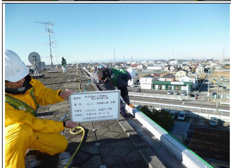
No. 15 5-1号棟・北側 パラペット 忌避テープ貼り 作業状況
