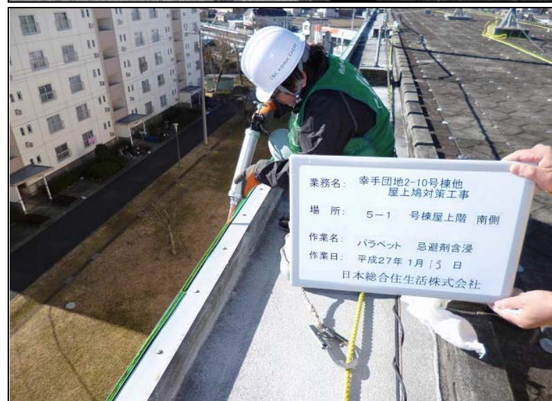
No. 18 5-1号棟・南側 パラペット 忌避剤含浸 作業状況
