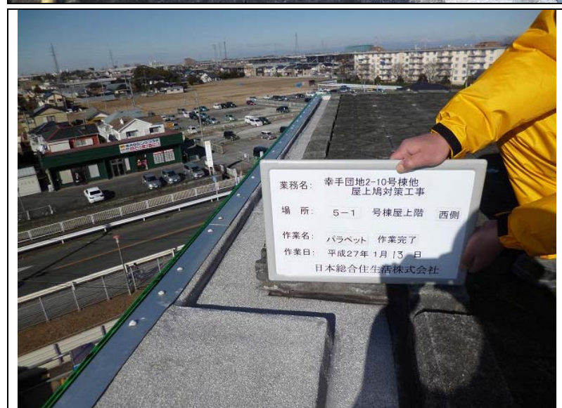
No. 21 5-1号棟・西側 パラペット 作業完了
