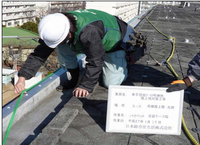
No. 55 5-3号棟・北側 パラペット 忌避テープ貼り 作業状況
