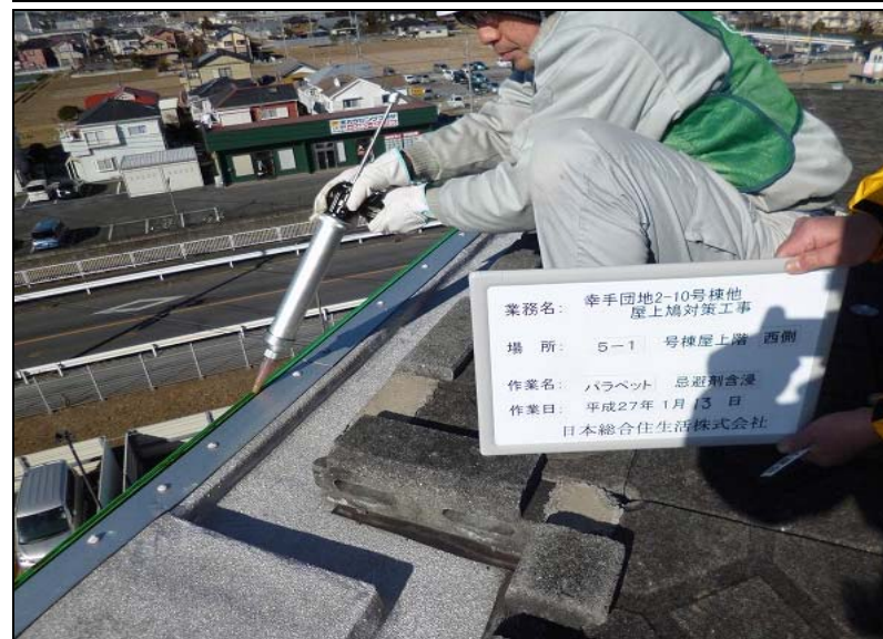
No. 17 5-1号棟・西側 パラペット 忌避剤含浸 作業状況
