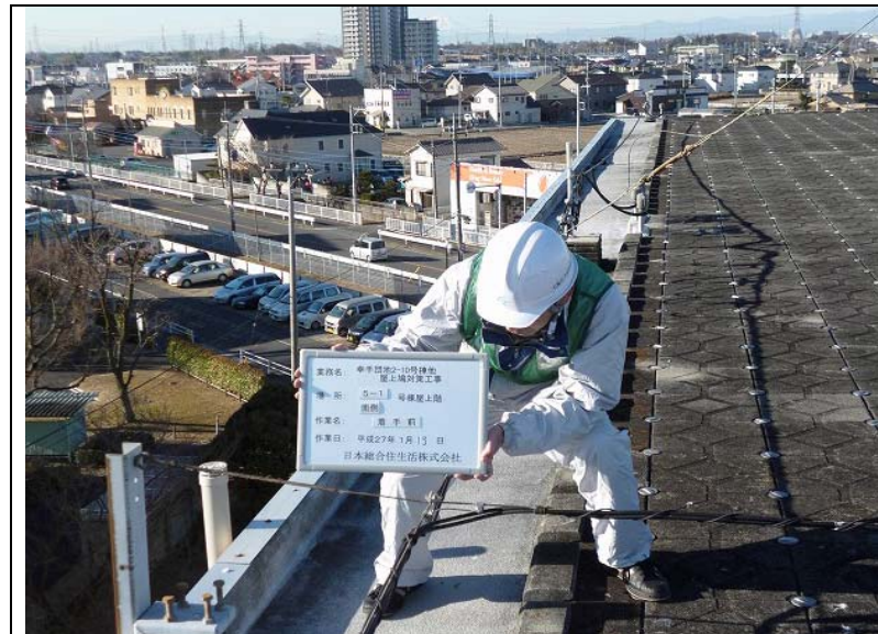
No. 6 5-1号棟・南側 着手前
