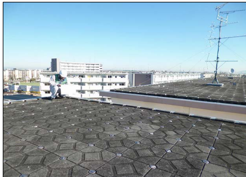
No. 4 5-1号棟・東側 着手前
