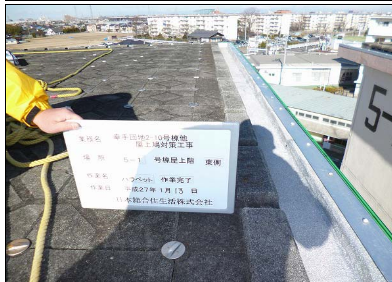
No. 20 5-1号棟・東側 パラペット 作業完了
