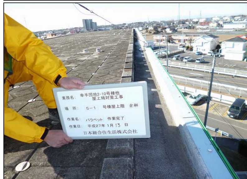
No. 23 5-1号棟・北側 パラペット 作業完了
