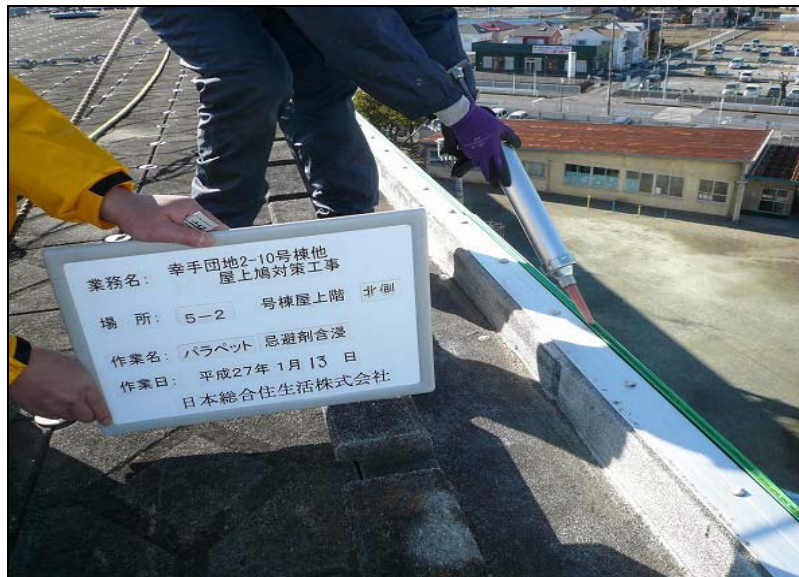
No. 39 5-2号棟・北側 パラペット 忌避剤含浸 作業状況
