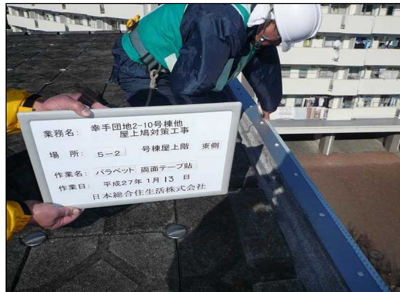
No. 28 5-2号棟・東側 パラペット 両面テープ貼り 作業状況
