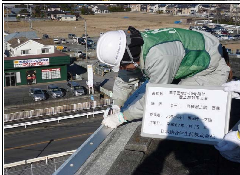
No. 9 5-1号棟・西側 パラペット 両面テープ貼り 作業状況
