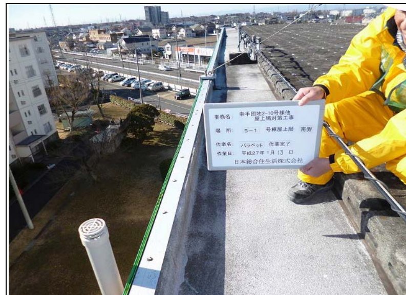
No. 22 5-1号棟・南側 パラペット 作業完了
