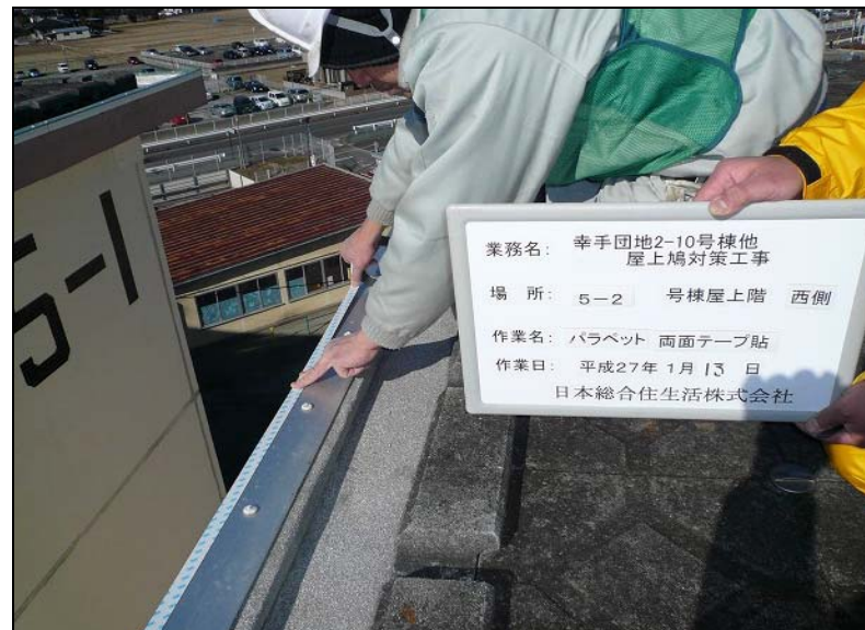
No. 29 5-2号棟・西側 パラペット 両面テープ貼り 作業状況
