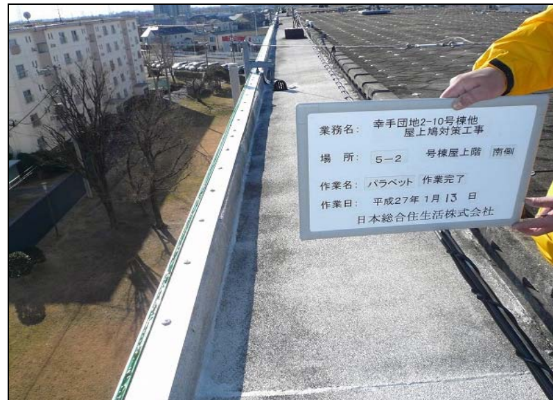
No. 42 5-2号棟・南側 パラペット 作業完了
