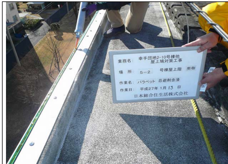
No. 38 5-2号棟・南側 パラペット 忌避剤含浸 作業状況
