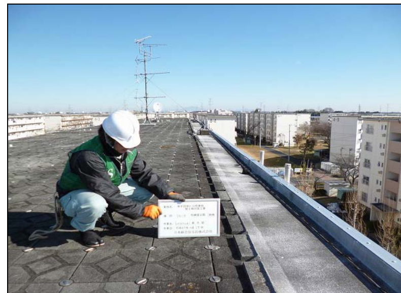
No. 46 5-3号棟・南側 着手前
