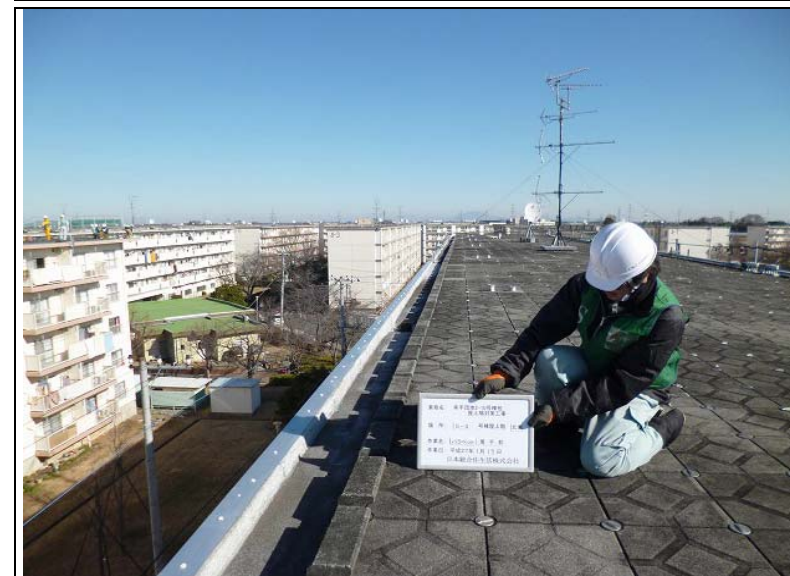
No. 47 5-3号棟・北側 着手前
