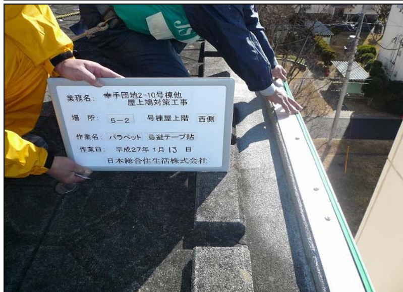
No. 33 5-2号棟・西側 パラペット 忌避テープ貼り 作業状況
