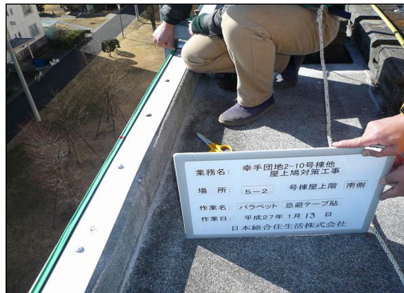
No. 34 5-2号棟・南側 パラペット 忌避テープ貼り 作業状況
