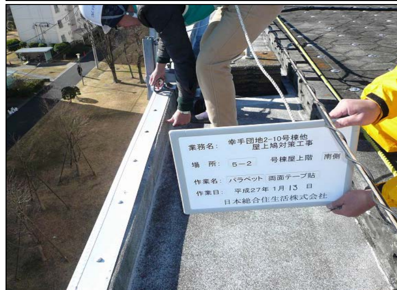
No. 30 5-2号棟・南側 パラペット 両面テープ貼り 作業状況
