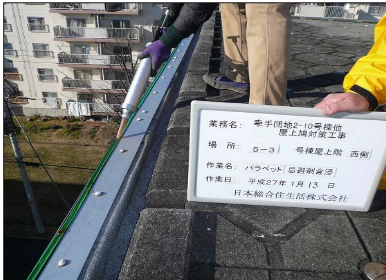
No. 57 5-3号棟・西側 パラペット 忌避剤含浸 作業状況
