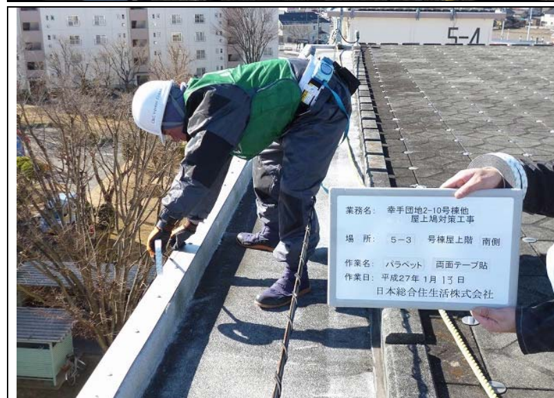
No. 50 5-3号棟・南側 パラペット 両面テープ貼り 作業状況
