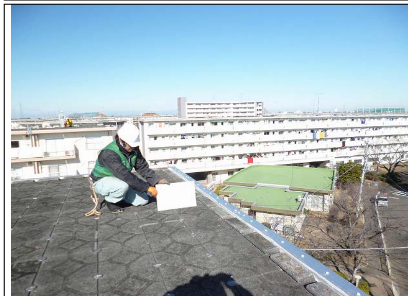
No. 44 5-3号棟・東側 着手前
