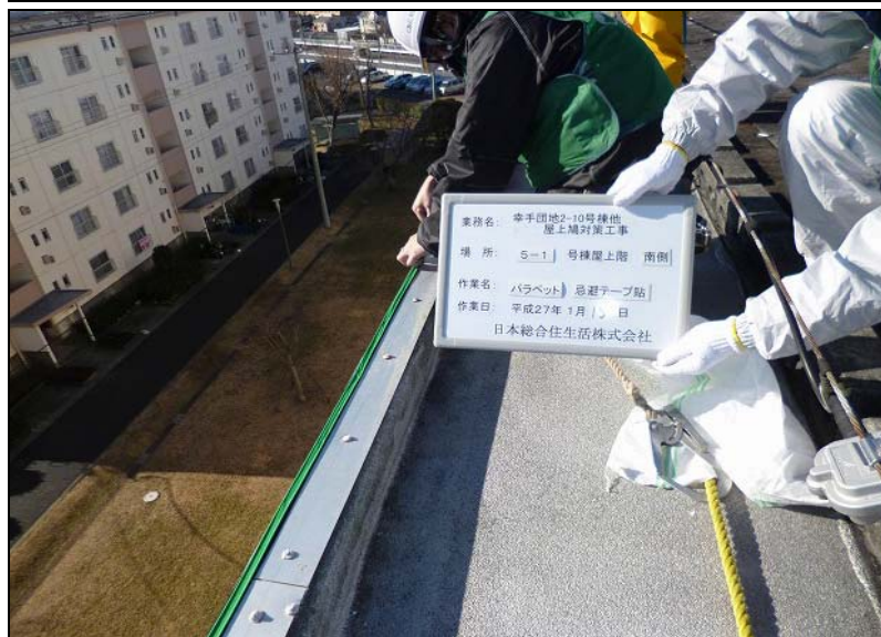
No. 14 5-1号棟・南側 パラペット 忌避テープ貼り 作業状況
