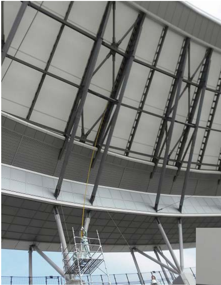
大屋根・トラスー 特殊作業棒による巣撤去作業状況
