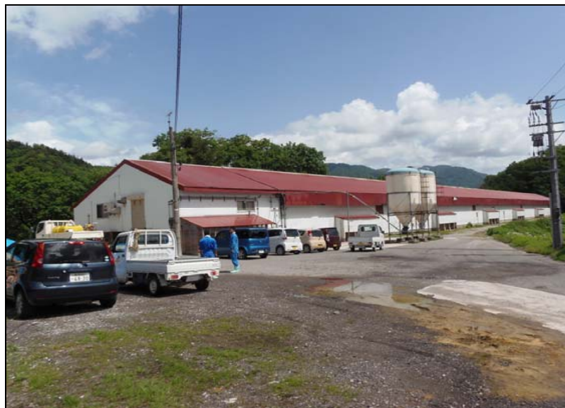
No. 1 環境対策 (ワクモ忌避) 作業 作業開始前 種鶏場 1号農舎 全景 1
