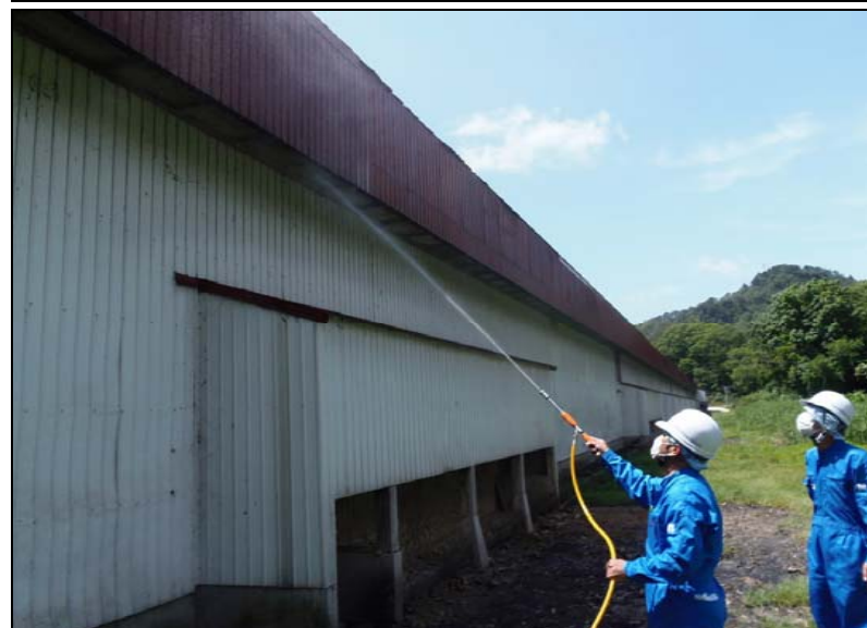
No. 9 環境対策 (ワクモ忌避) 作業 北面・外壁 (軒裏) 忌避剤散布
