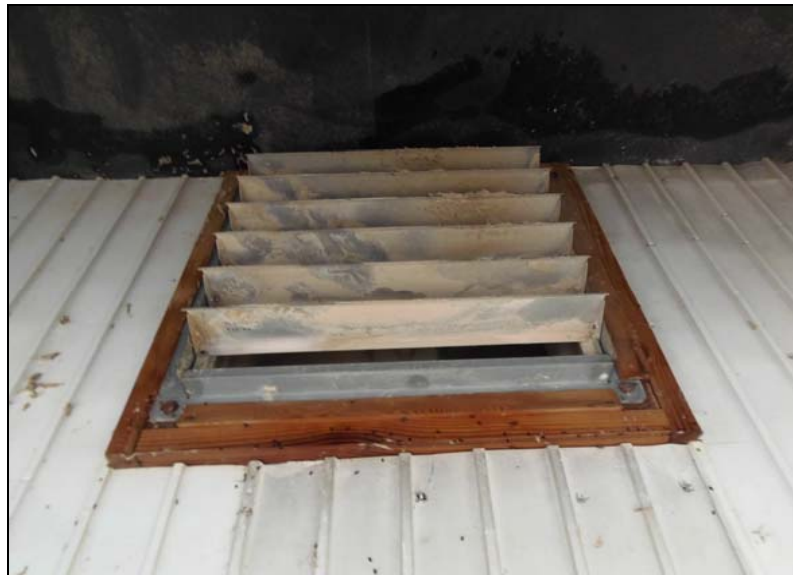
№. 14 環境対策 (ワクモ忌避) 作業 換気扇室状況 2
