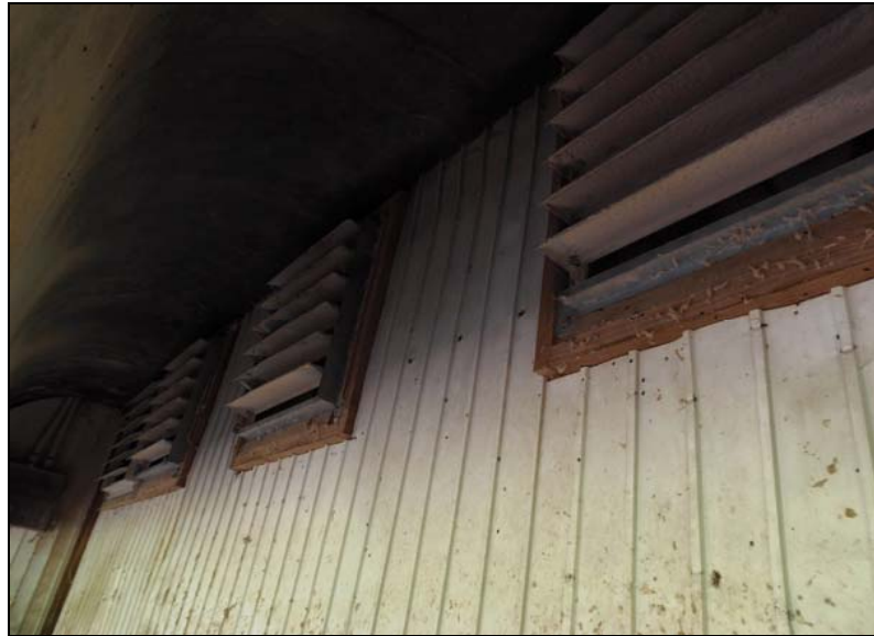
№. 13 環境対策 (ワクモ忌避) 作業 換気扇室状況 1
