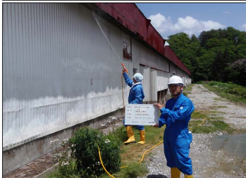
№. 21 環境対策 (ワクモ忌避) 作業 南面・外壁 (軒裏) 忌避剤散布 2
