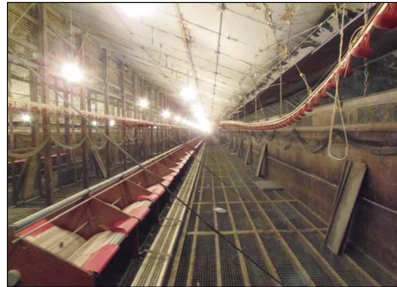
№. 28 環境対策 (ワクモ忌避) 作業 種鶏場内 作業開始前 4 5室から8室 右側を望む
