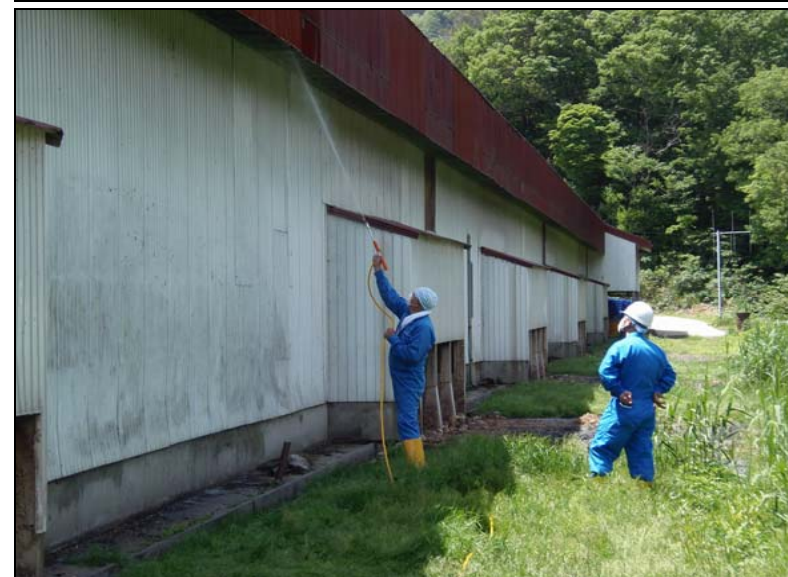
No. 12 環境対策 (ワクモ忌避) 作業 北面・外壁 忌避剤散布 2
