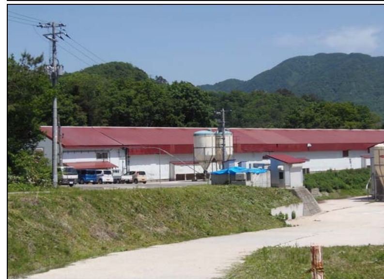
No. 48 環境対策 (ワクモ忌避) 作業 作業完了全景
