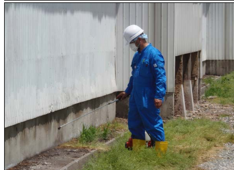
№. 18 環境対策 (ワクモ忌避) 作業 南面・外壁 立ち上り基礎部 忌避剤散布 (背負い式 動力噴霧器)
