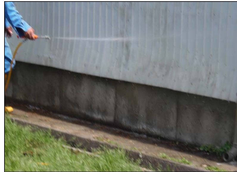
№. 22 環境対策 (ワクモ忌避) 作業 南面・外壁 忌避剤散布
