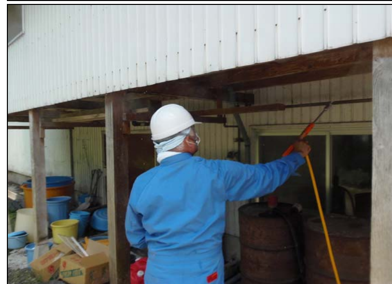
№. 24 環境対策 (ワクモ忌避) 作業 西面・外壁 木製部 (ひび割れ部分) 忌避剤散布
