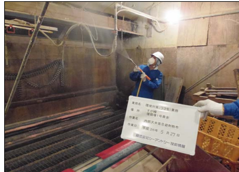
№. 29 環境対策 (ワクモ忌避) 作業 種鶏場天井面 忌避剤散布 1
