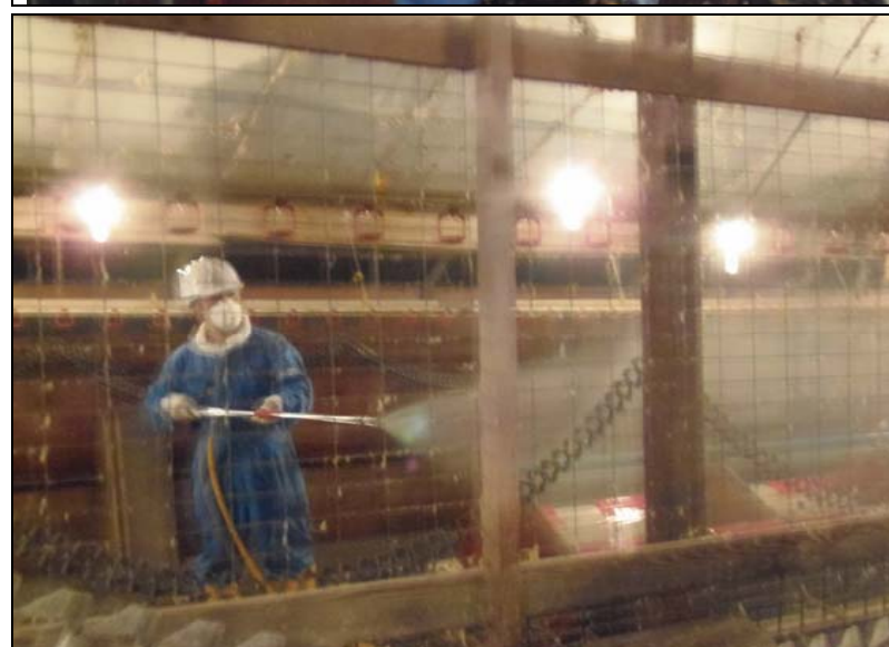
№. 39 環境対策 (ワクモ忌避) 作業 種鶏場 仕切壁柱 (木製柱ひび割部) 忌避剤散布
