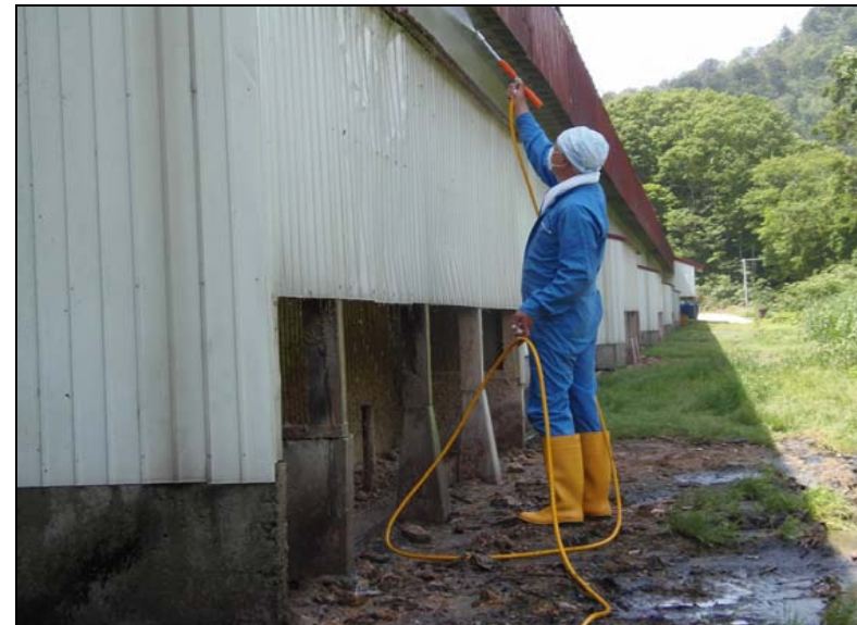
No. 11 環境対策 (ワクモ忌避) 作業 北面・外壁 忌避剤散布 1
