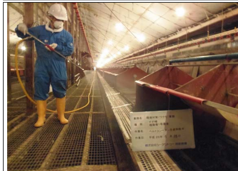
No. 44 環境対策 (ワクモ忌避) 作業 ベルトコンベアー 忌避剤散布 1
