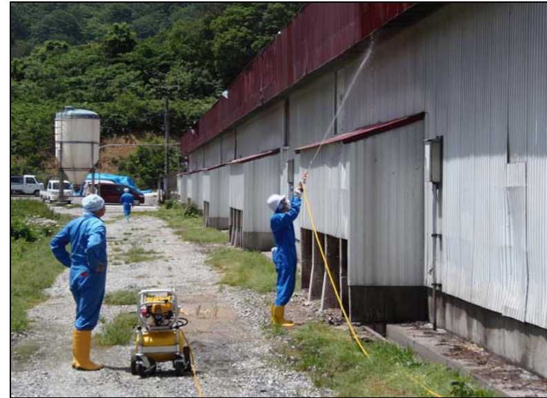
№. 16 環境対策 (ワクモ忌避) 作業 南面・外壁 忌避剤散布 2
