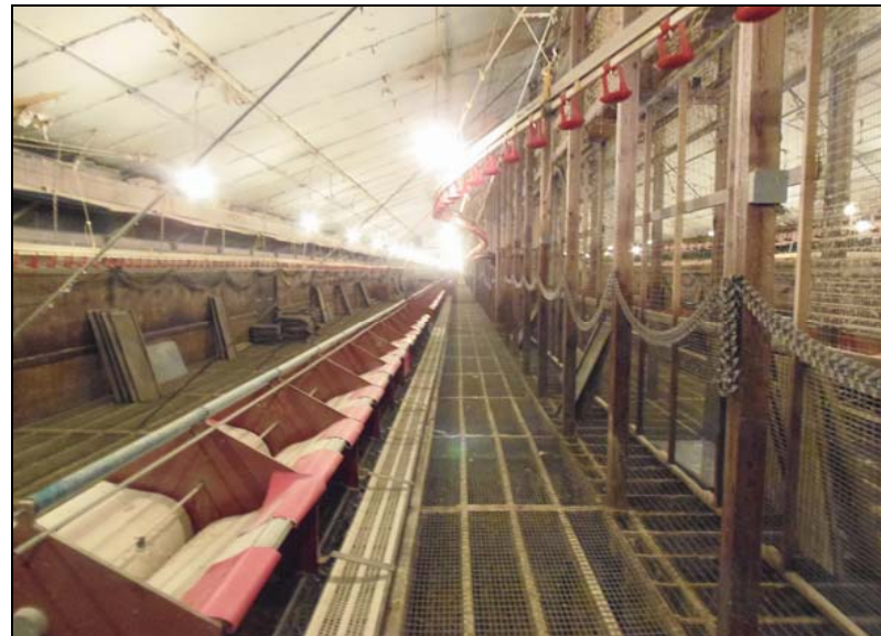
№. 26 環境対策 (ワクモ忌避) 作業 種鶏場内 作業開始前 2 1室から4室 右側を望む
