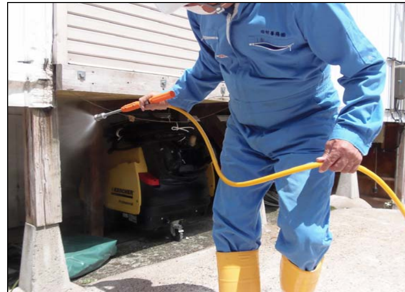
№. 23 環境対策 (ワクモ忌避) 作業 西面・外壁 木製柱部 (ひび割れ部分) 忌避剤散布
