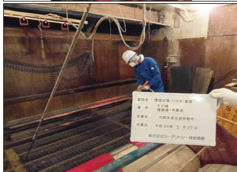
No. 35 環境対策 (ワクモ忌避) 作業 種鶏場床面 忌避剤散布 1
