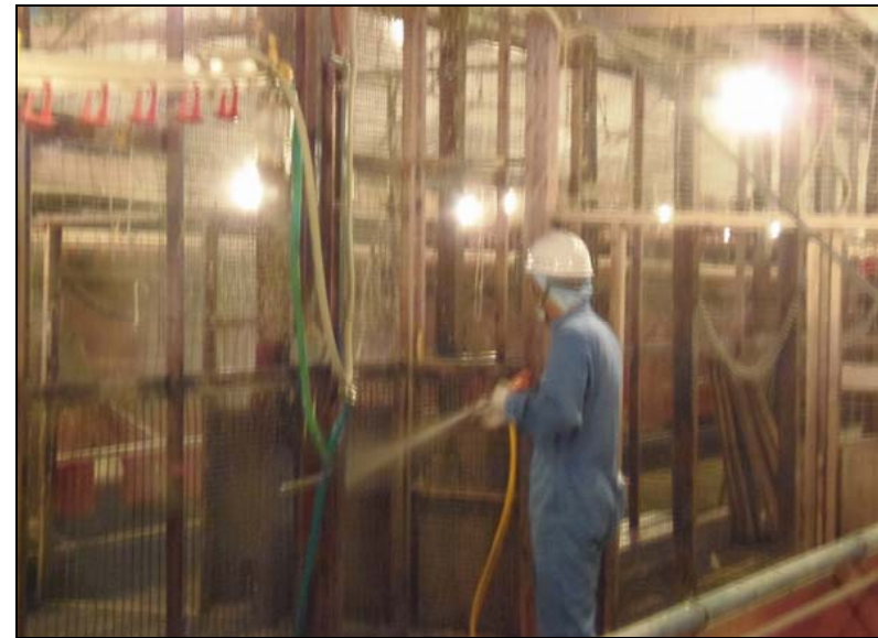
№. 40 環境対策 (ワクモ忌避) 作業 種鶏場 仕切壁 忌避剤散布
