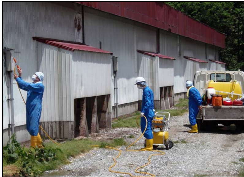
№. 19 環境対策 (ワクモ忌避) 作業 南面・外壁接続部 忌避剤散布
