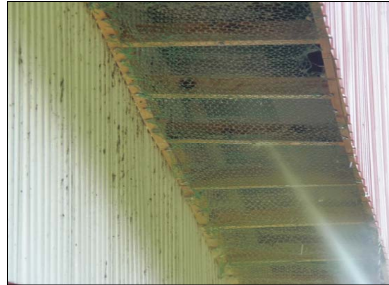
No. 10 環境対策 (ワクモ忌避) 作業 北面・外壁 (軒裏) 忌避剤散布 (拡大)
