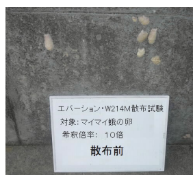
スノーシェード壁面 忌避剤・散布前
