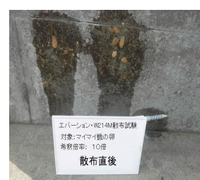
スノーシェード壁面 忌避剤・散布後
