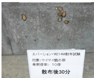
スノーシェード壁面 忌避剤・散布後30分経過
