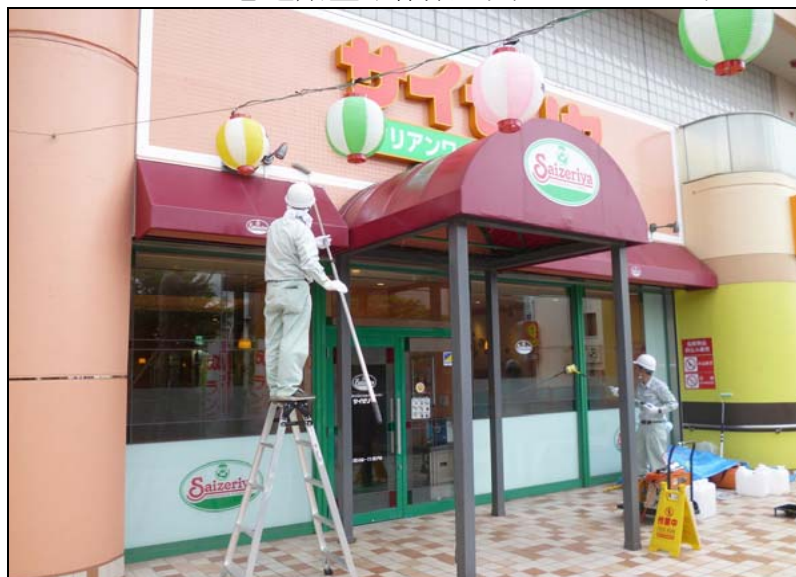
No. 7 エポカビアガーデン テント忌避剤塗布 状況 2
