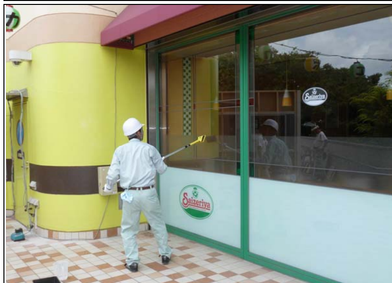
No. 9 エポカビアガーデン ガラス面忌避剤塗布 状況 2
