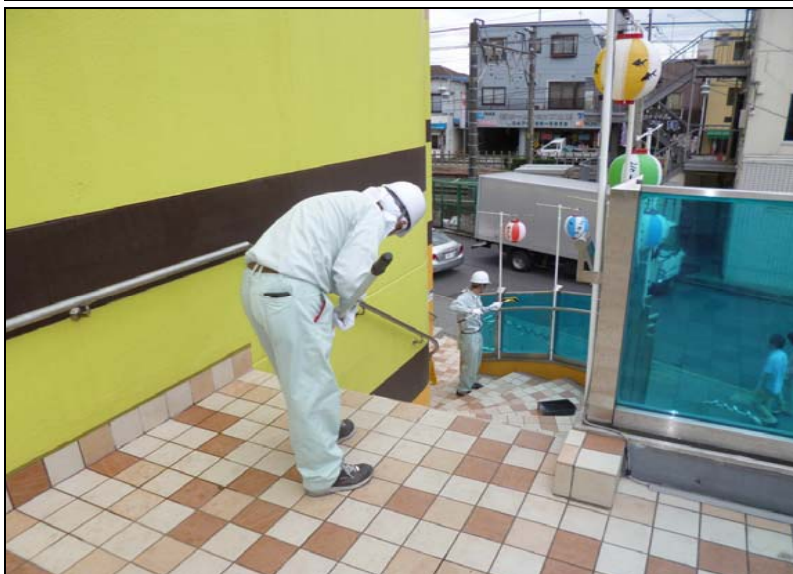
No. 14 エポカビアガーデン 壁面、フェンス ・忌避剤塗布 状況
