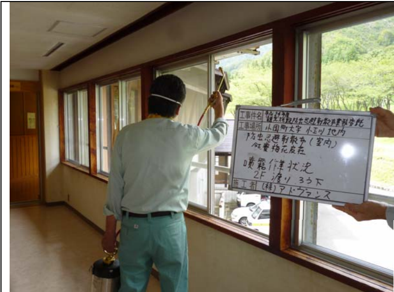
No. 7 飯豊梅花皮荘・室内 2F 渡り廊下 忌避剤 (FB-14) 散布作業
