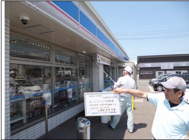
No. 7 防虫忌避剤 ひばの力 #041・Y1Y (看板下天井部) 塗布状況 1
