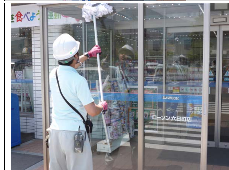
No. 6 防虫忌避剤 塗布前清掃状況 3 (風除け室ガラス部)
