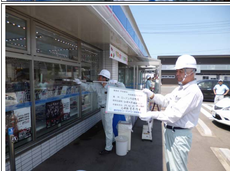
No. 9 防虫忌避剤 ひばの力 #041・Y5Y (ガラス用) 塗布状況 3 (正面ガラス部)
