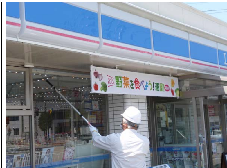
No. 8 防虫忌避剤 ひばの力 #041・Y1Y (看板下天井部) 塗布状況 2
