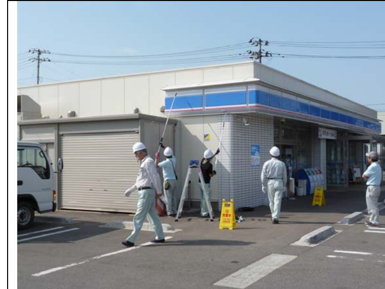
No. 17 防虫忌避剤 ひばの力 #041・Y1Y 塗布状況 11 (店舗看板・側面)
