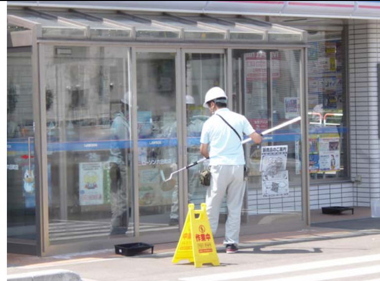
No. 14 防虫忌避剤 ひばの力 #041・Y1Y 塗布状況 8 (風除け室全景)
