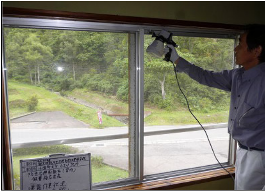
山形県小国町・川入荘ーカメムシ防虫忌避対策 室内・玄関窓枠ー忌避剤散布
